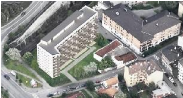
Sotahjørnet – ny blokk. Foto: Dagsavisen 22.11
